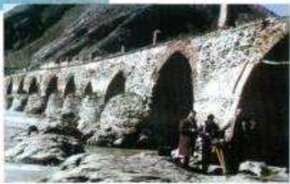
Сəбрайл rayonu. Худафəрин кəрпүсүндən бир гəрүнүш. Jabrayil region. A view of Hudaferin Bridge. Джабраилский район. Вид с Худаферинского моста.
