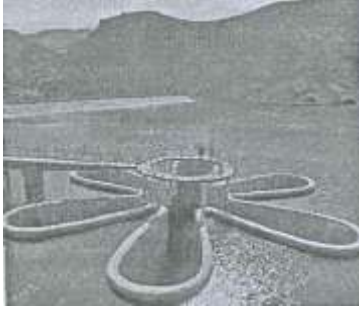
Bazar çay üzərində Şam SES-in görünüşü.
